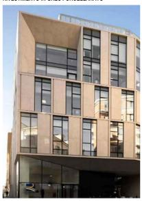
Il rivestimento in lastre di gres porcellanato a grandi dimensioni tipo Ceramaster o equivalente con alta classe di prefabbricazione degli elementi, alta produttività in termini acustici e di trasmissione termica. Supporto di ancoraggio con profili in alluminio anodizzato.
