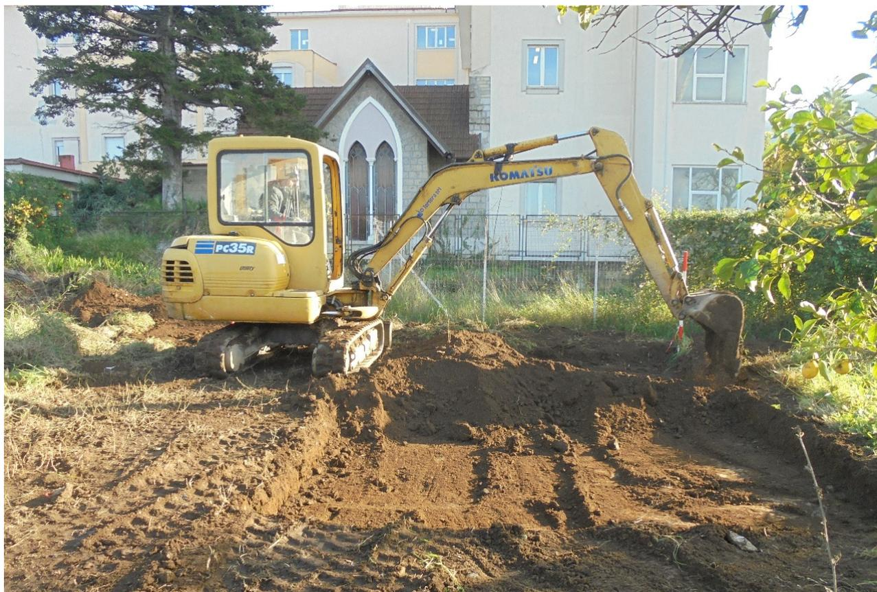
Fig. 18. SG3, sbancamento superficiale con mezzo meccanico.
