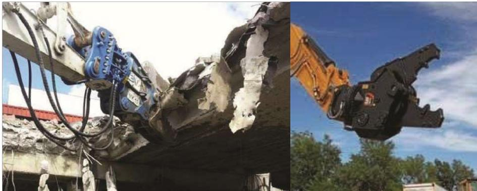
Figura 3 – Lavorazione di demolizione con pinza e particolare di una pinza
