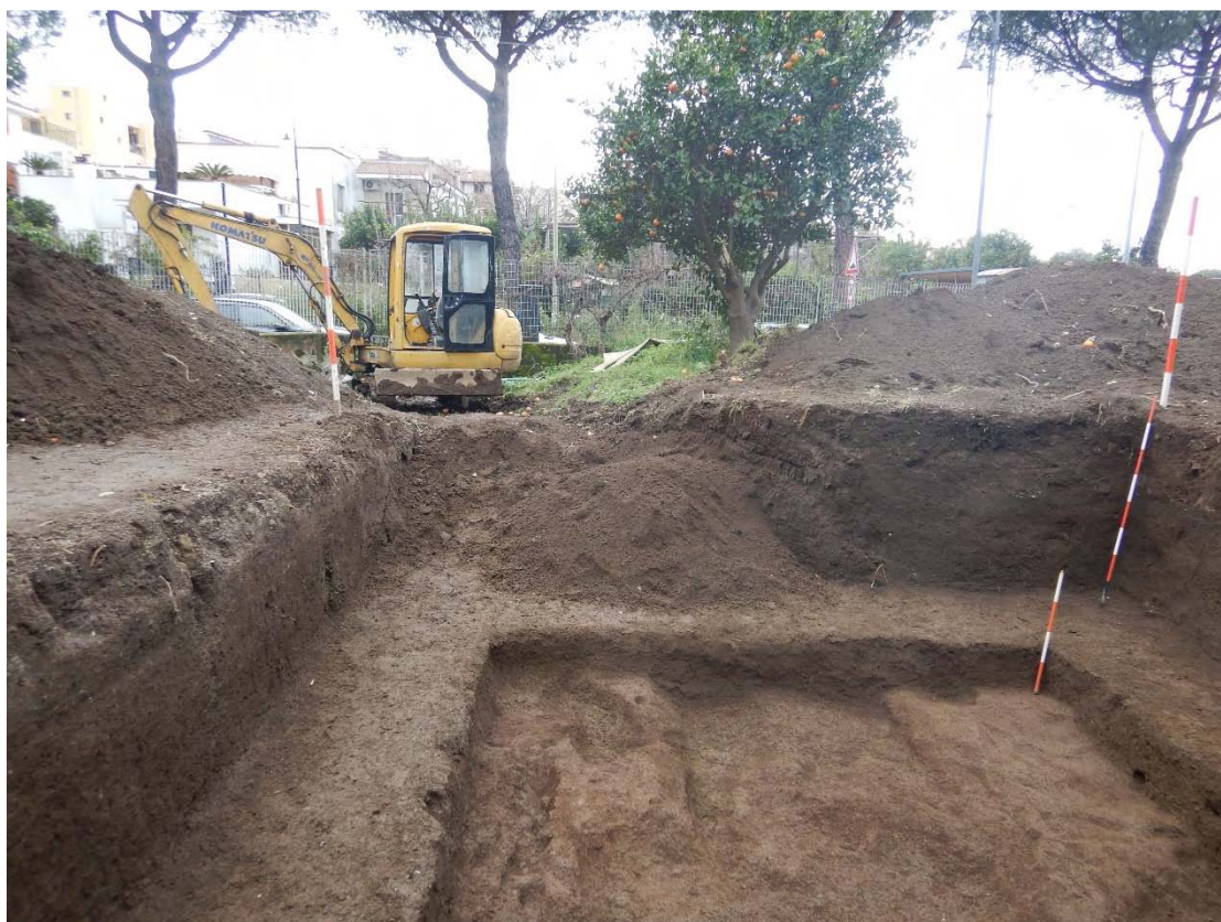
Fig. 26. SG4, sezione di scavo al momento della realizzazione della rampa d'accesso a fondo scavo.
