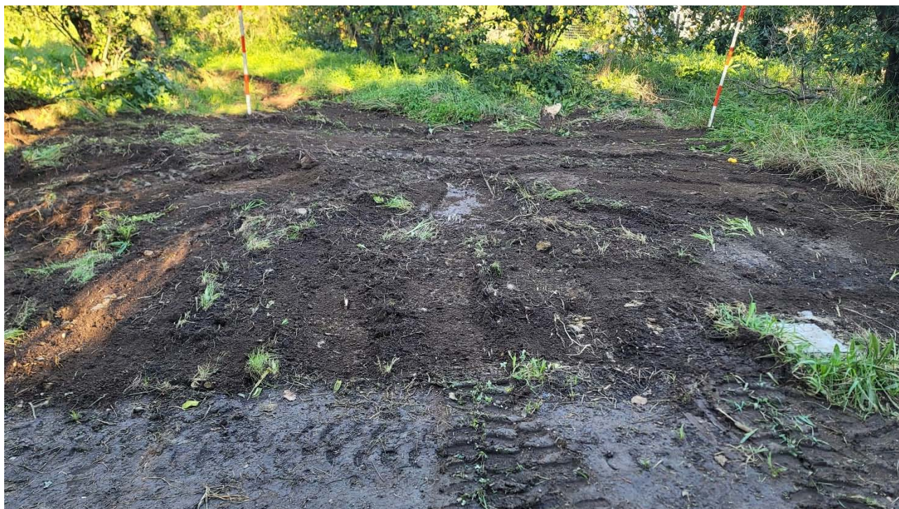
Fig. 24. SG4, area di scavo al momento dell'inizio dei lavori.
