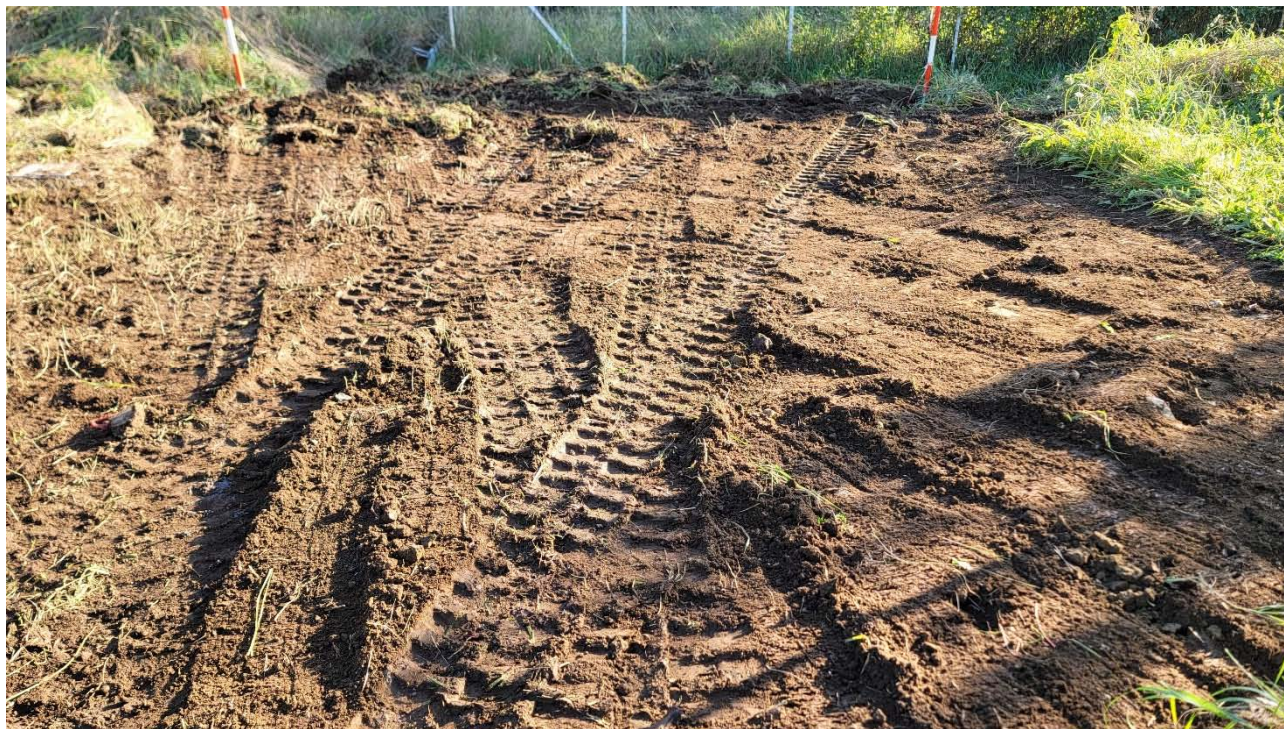
Fig. 17. SG3, area di scavo al momento dell'inizio dei lavori.
