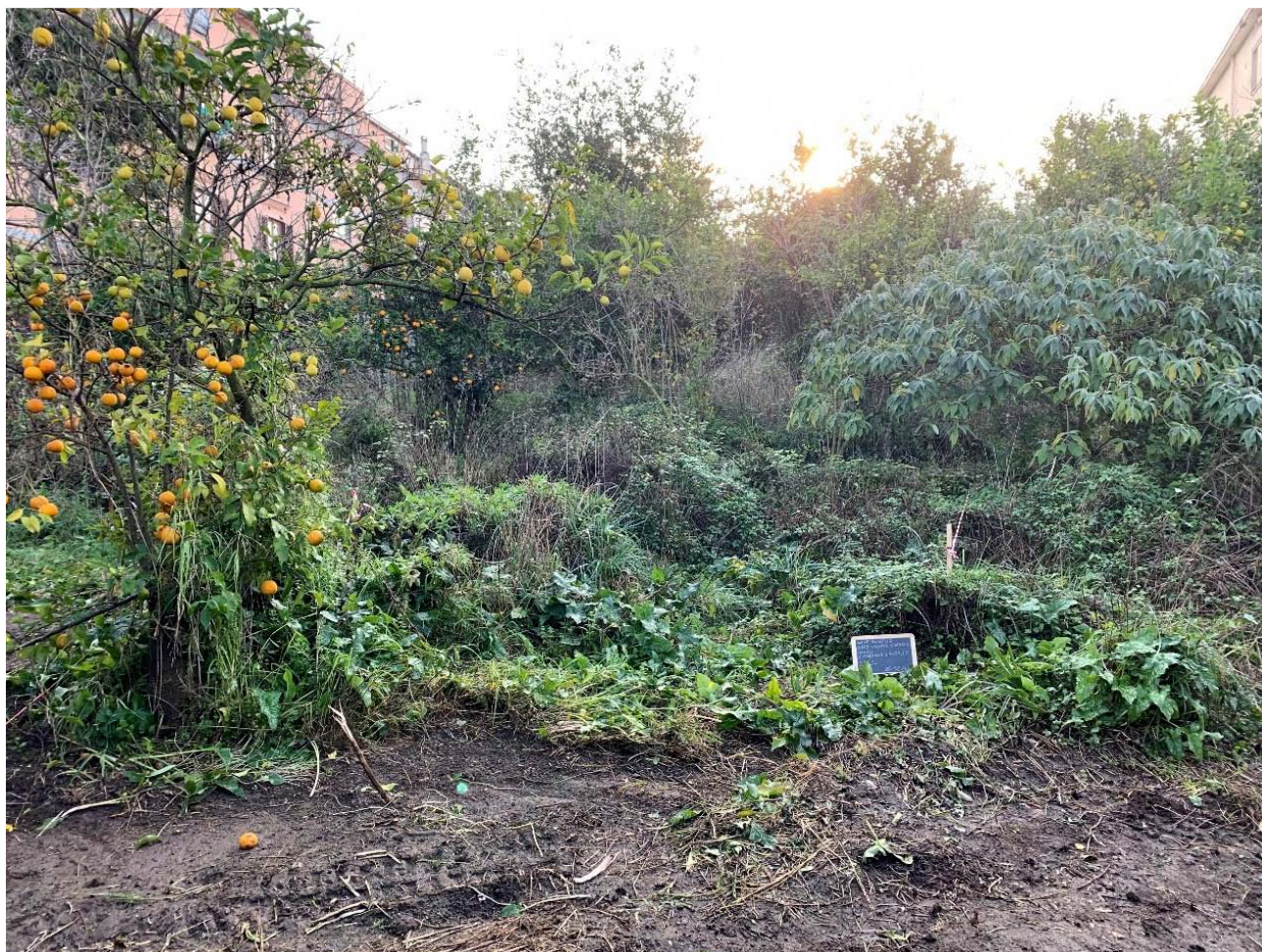
Fig. 5. SG1, area di scavo al momento dell'inizio dei lavori.
