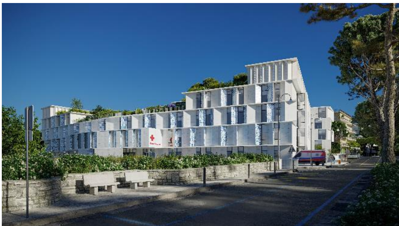
Vista da Viale dei Pini
