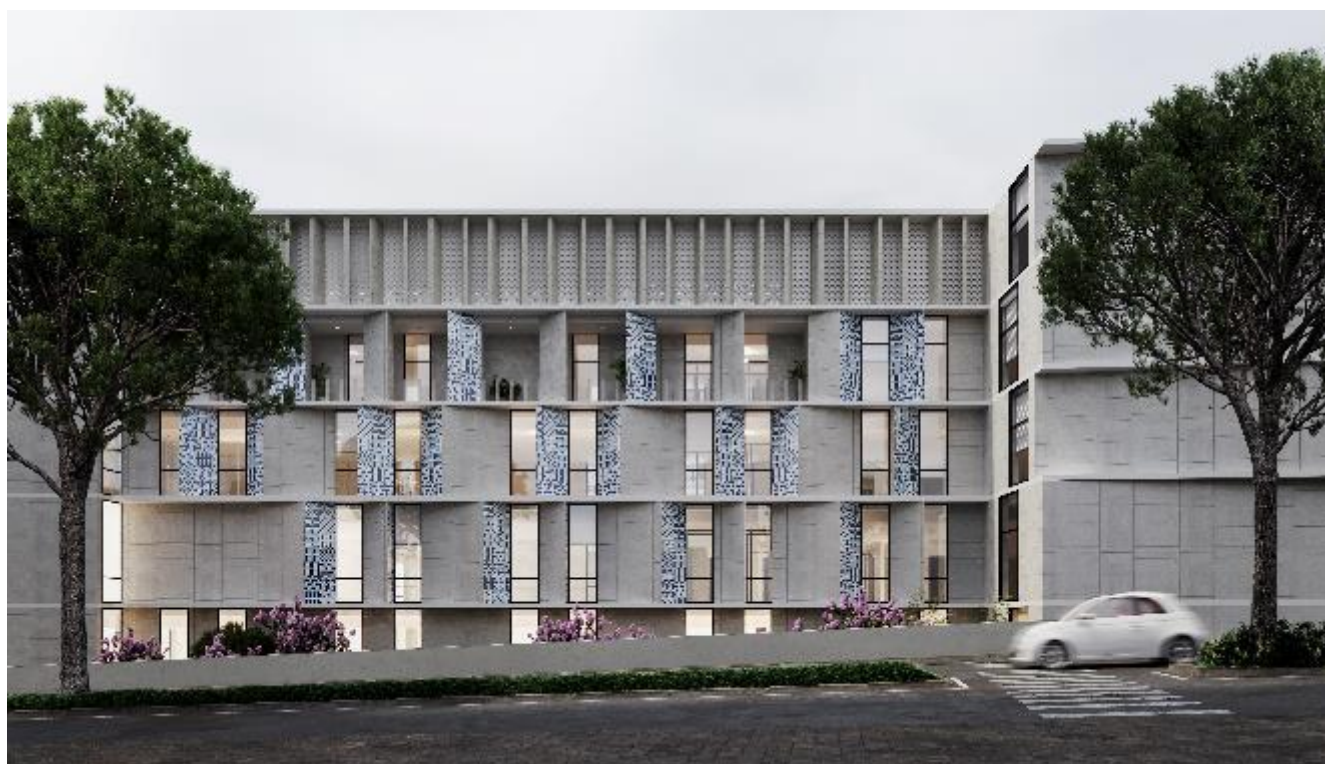
Vista da Viale dei Pini
